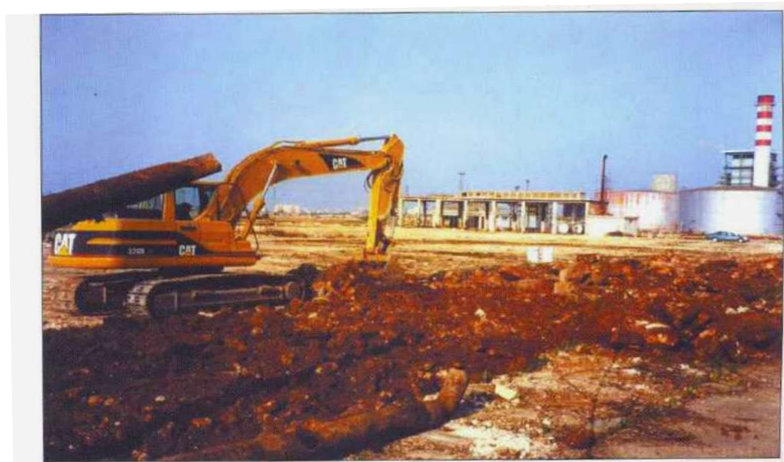
Tav. 8.18 Attività di landfarming in situ nel sito della ex raffineria Stanic di Bari.
