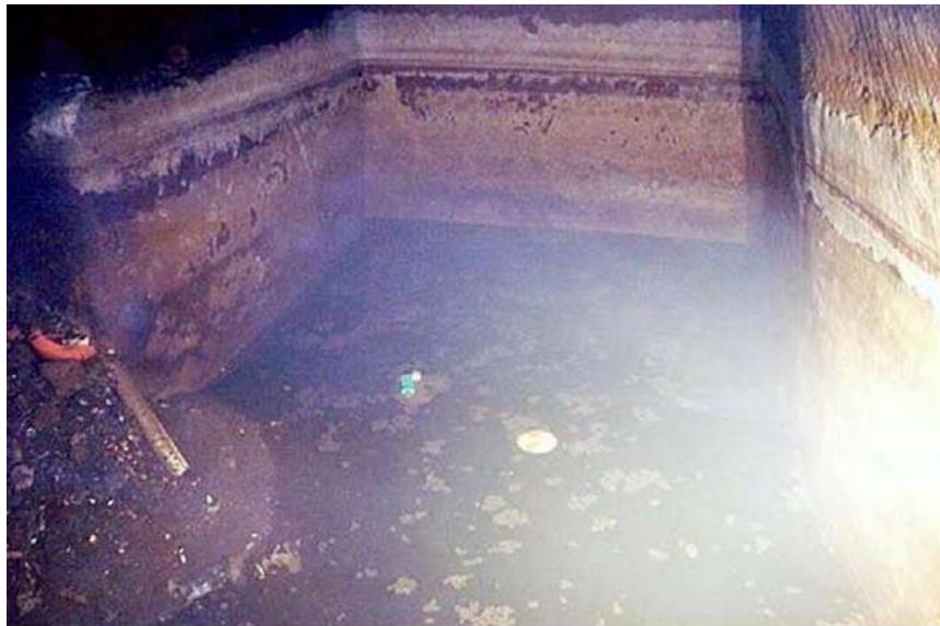
Vicolo Santa Maria Apparente, zone corso V. Emanuele, liquami sversati da scarico fognario abusivo; aria totalmente irrespirabile
